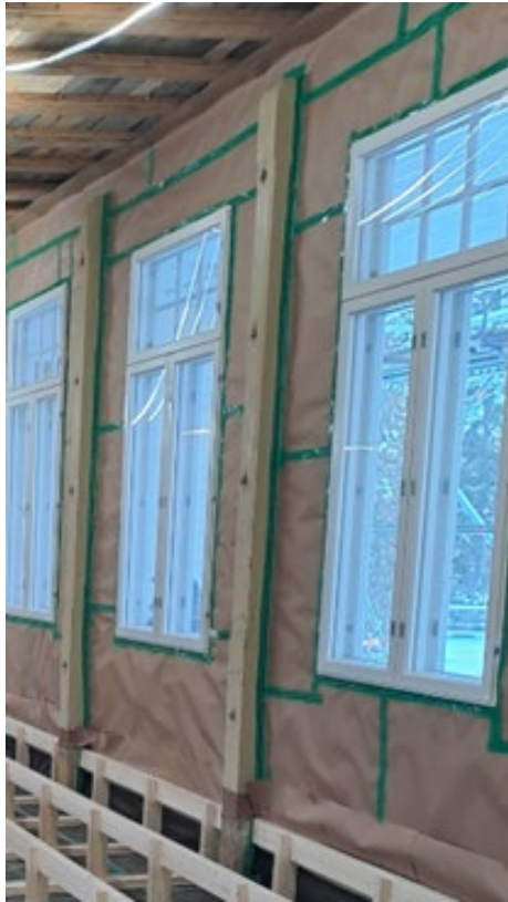
Kuvio 3. Ilmansulkupaperi teipattuna ikkunan karmiin.
