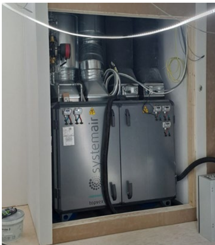
Kuvio 6. Tornion Niilontalossa oleva ilmanvaihtokone 1/8
